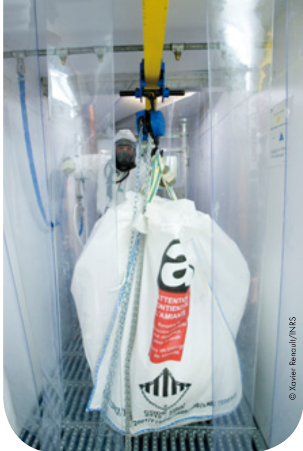
Tunnel déchets équipé de moyens de manutention.
