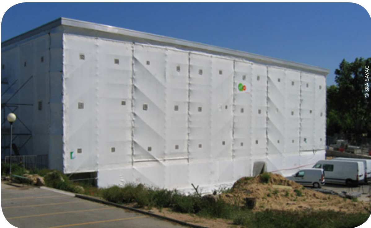
Confinement total d'un bâtiment.
