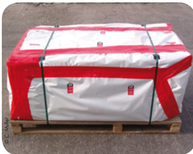
Emballage de plaques d'amiante-ciment sur palette
