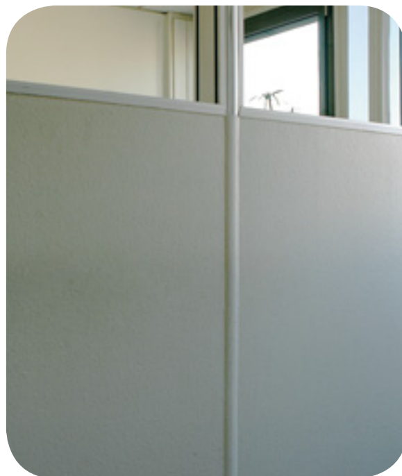
Cloison en amiante-ciment.
