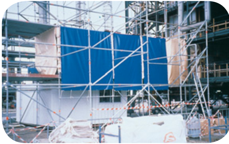
Confinement à l'extérieur d'une installation industrielle.
