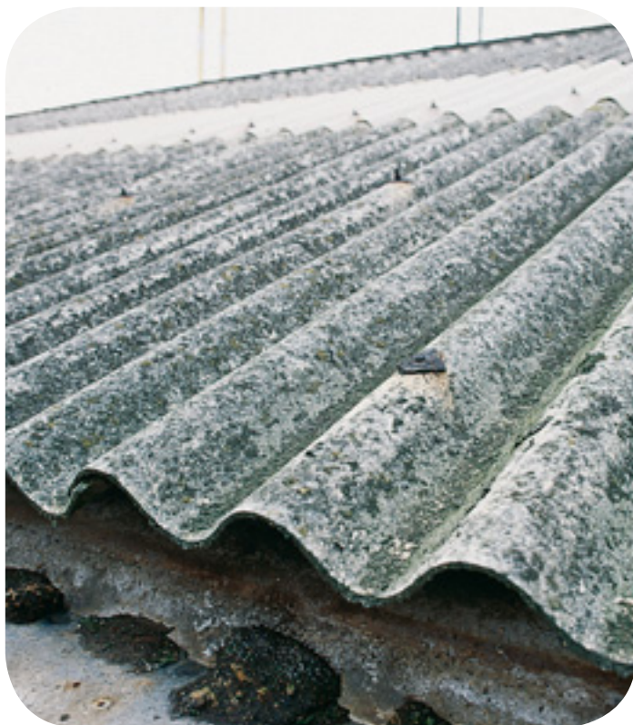
Toiture en amiante-ciment.
