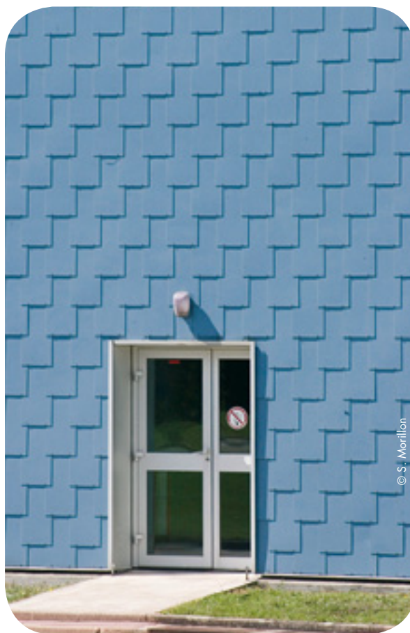
Bardage en amiante-ciment.
