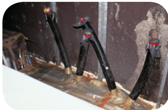
Installation électrique mise hors-service et gaine de passage obstruée.
