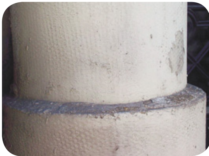
Conduite en amiante-ciment à l'intérieur d'un local
