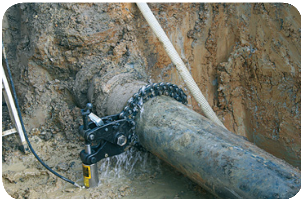
Découpe de canalisation en amiante-ciment au coupe-tube.
