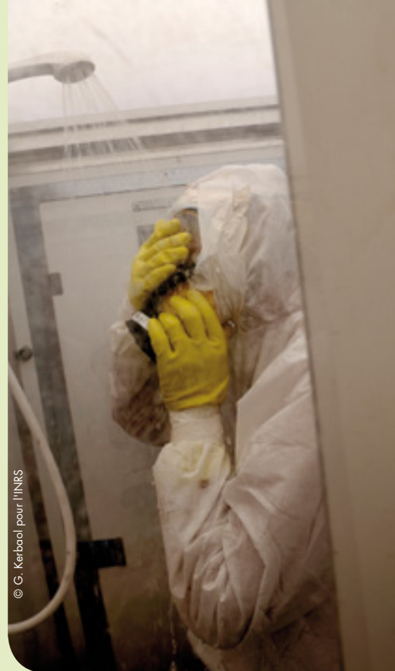
Nettoyage du masque et de la combinaison sous la douche dans le quatrième compartiment du tunnel.
