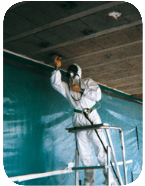
Travail de finition sur une nacelle mobile.
