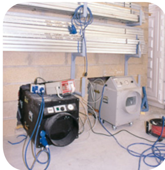
Extraction de l'air filtré et dispositif externe de contrôle de la dépression.
