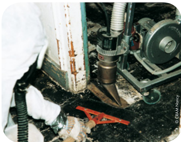
Décollement des dalles à la spatule.
