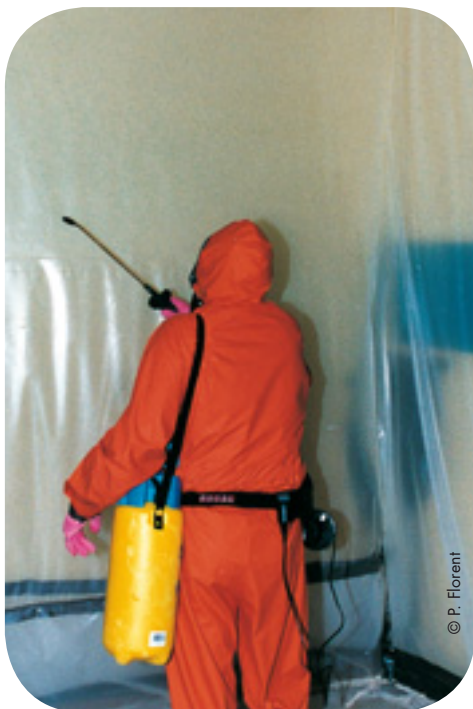
Application d'un surfactant sur les films.
