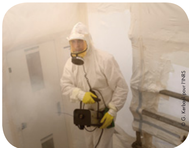
Test de fumée à l'intérieur du confinement.
