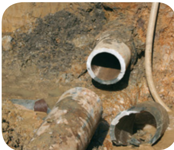
Canalisations en amiante-ciment.
