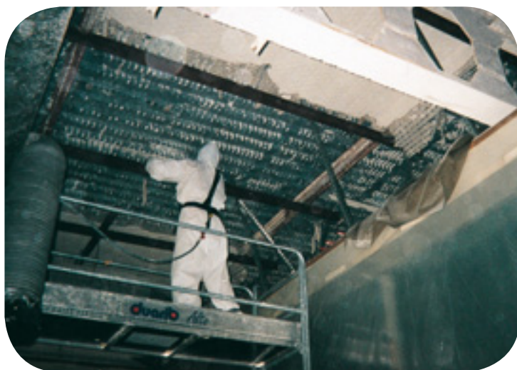
Retrait d'un enduit plâtreux projeté.
