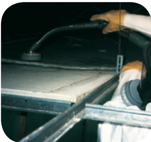
Aspiration de la face supérieure avant dépose de la plaque.
